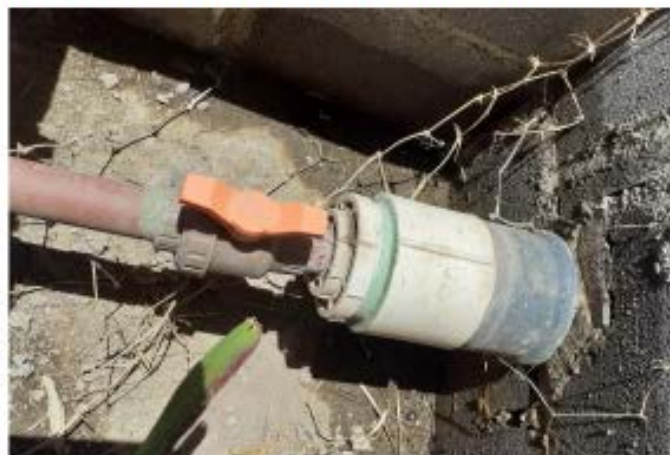
Figura 5.5-10 Válvula Esférica V10 (Fuente: Propia)
