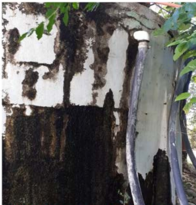
Figura 5.5-5 Conexión de cisterna B a C (Fuente: Propia)
