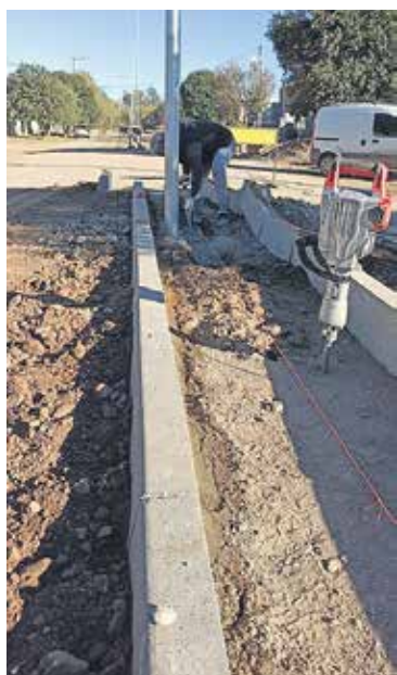
Obras en barrio Residencial Rural.
