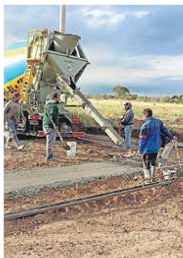
Obras en barrio Bicentenario.
